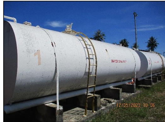
ถังน้ำสำรองสำหรับการดับเพลิง
